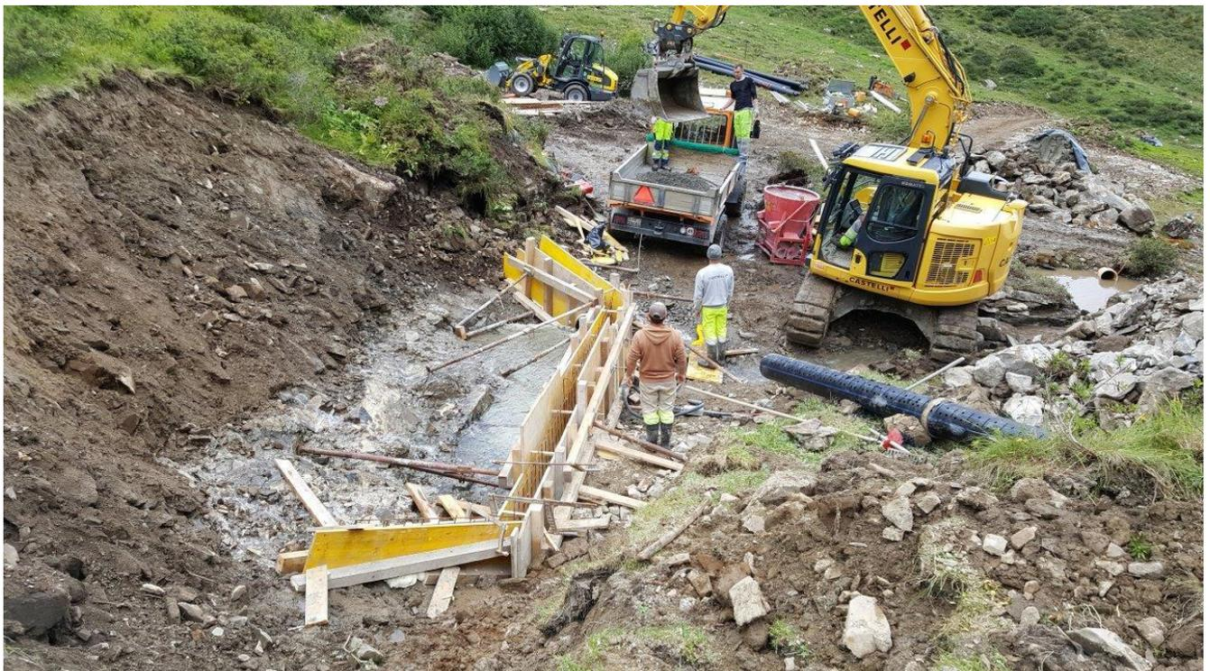
24.08.2021: Die Quelle Nr.4 ist freigelegt und der Betonriegel wird erstellt
