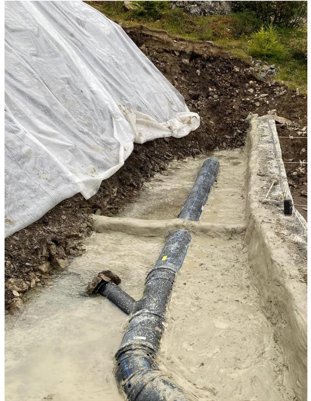
Quelle Nr.1: Quelle wird mit Lehm abgedichtet
