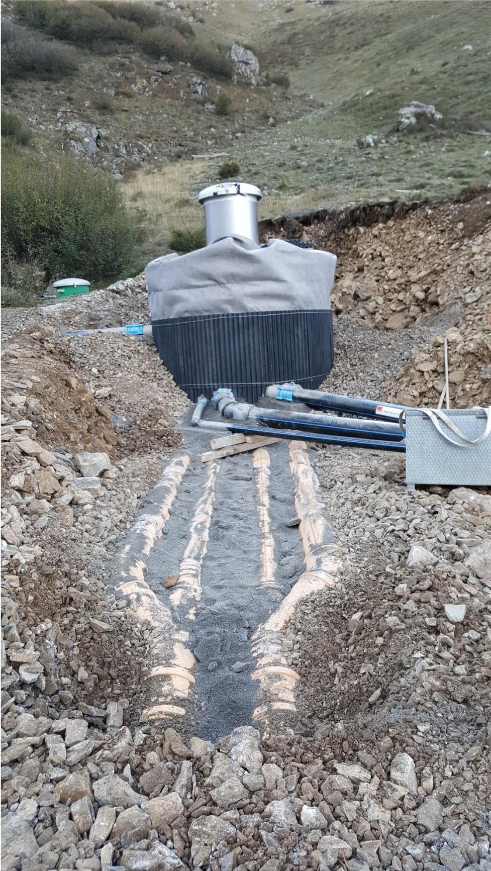
21.09.2022: Die Brunnenstube BS 1 ist auf sehr grosse Quellschüttungsmengen ausgelegt. Die max. Zulaufmenge ins Dorf beträgt 132 l/s. Die max. Überlaufmenge beträgt beachtliche 390 l/s
