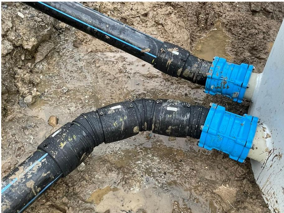
15.09.2023: Quellfassungen 7 und 8 mit PE-Rohren und Guss-Kupplungen an Brst 2 angeschlossen.
