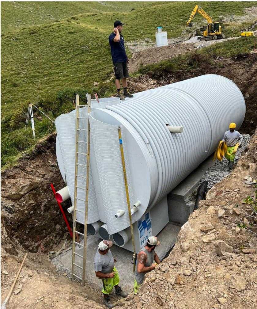
24.08.2023: Klein-Reservoir (Innen: Länge 7.5 m, Durchmesser 3.0 m) versetzt auf Betonsohle.
