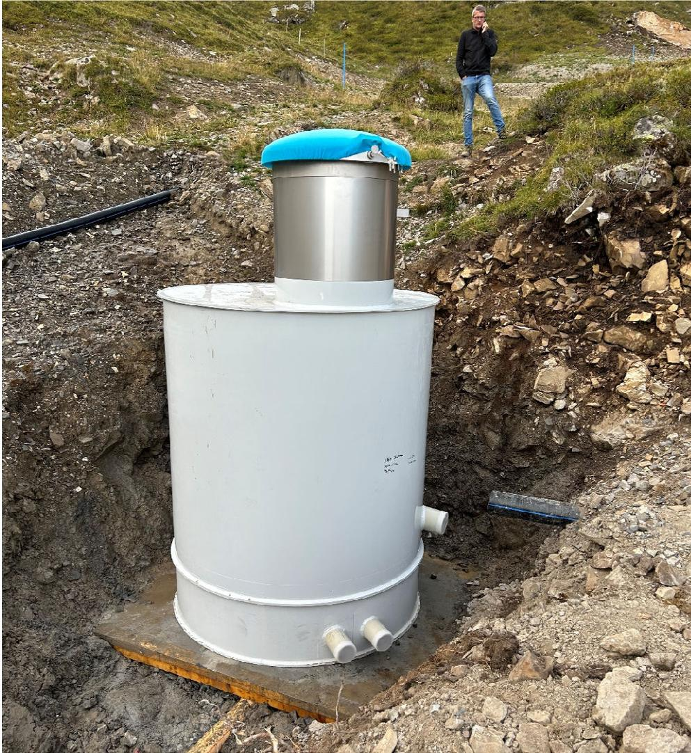
12.09.2023: Brunnenstube 2 (Durchmesser 2.0 m, Höhe 3.7 m) in Baugrube versetzt.
