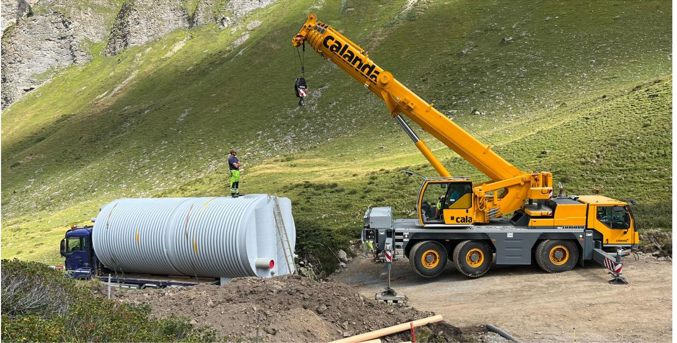
24.08.2023: Klein-Reservoir mit 3-Achser geliefert und bereit zum Versetzen mit Mobilkran
