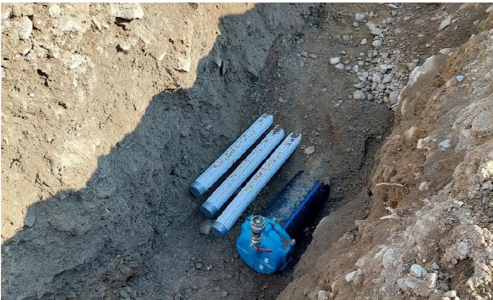
06.06.2023: Verlegte Kabelschutzrohre DN100 und Druckleitung DN315 mit Feinmaterial umhüllt.
