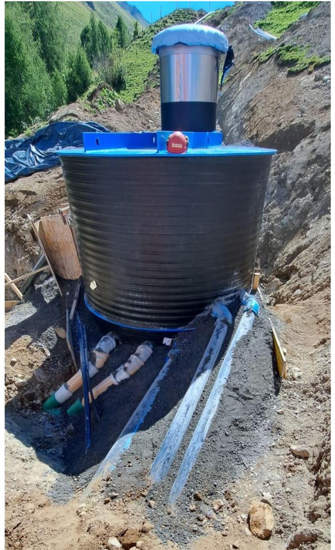
18.08.2023: Sammelschacht Farur mit angeschlossenen Zu- und Auslauleitungen aus PE und mit Überlaufleitungen aus PP. Die Leitungen wurden alle unterbetoniert gegen das Abscheren.
