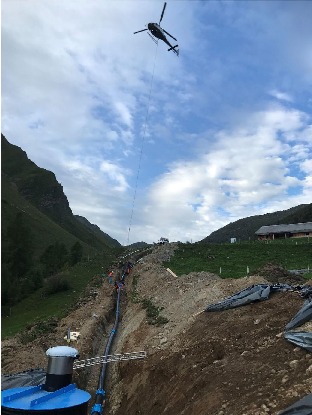
15.08.2023: Sammelschacht Farur versetzt. Verlegung der PE-Rohre DN315 mit Helikopter.
