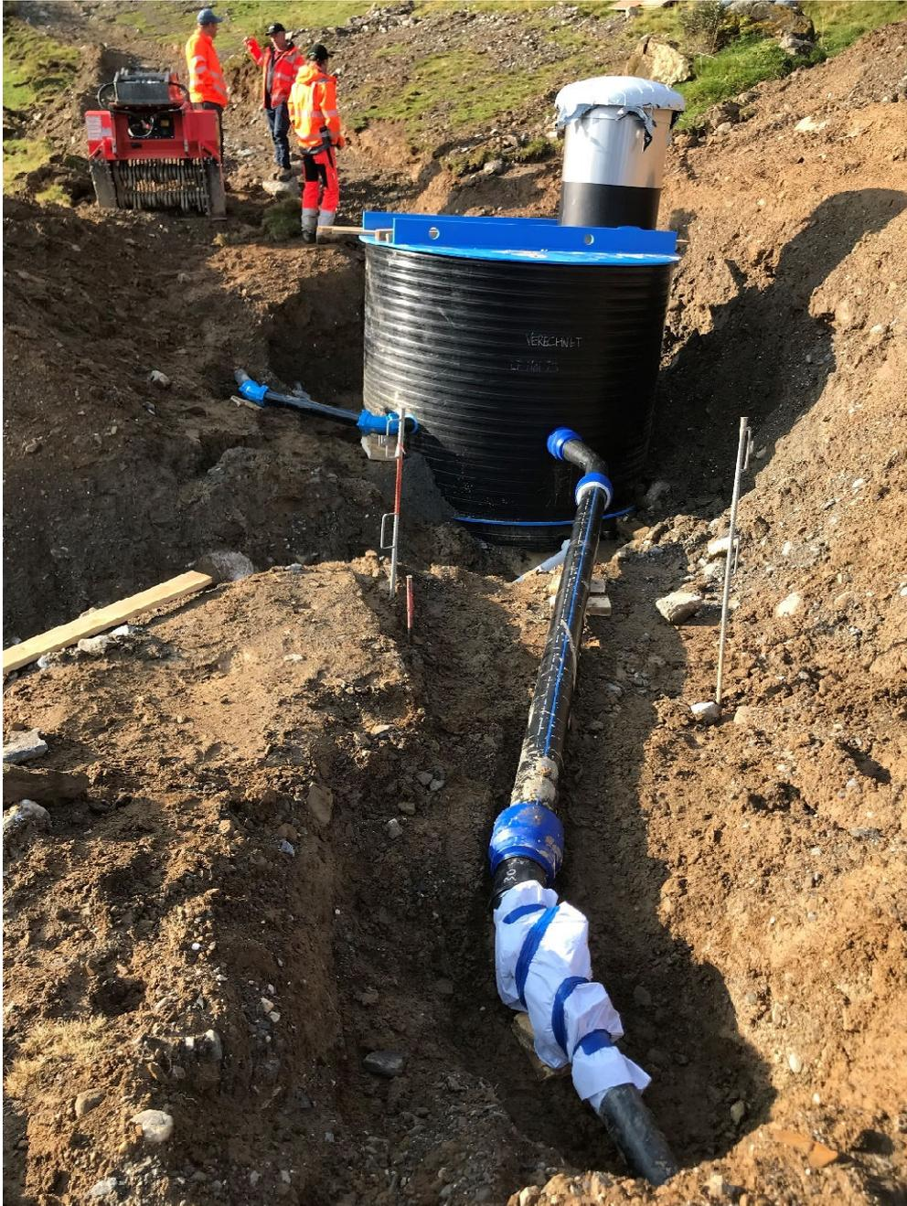
31.08.2023: Der Druckreduzierschacht Farur ist versetzt. Und fertig angeschlossen.
