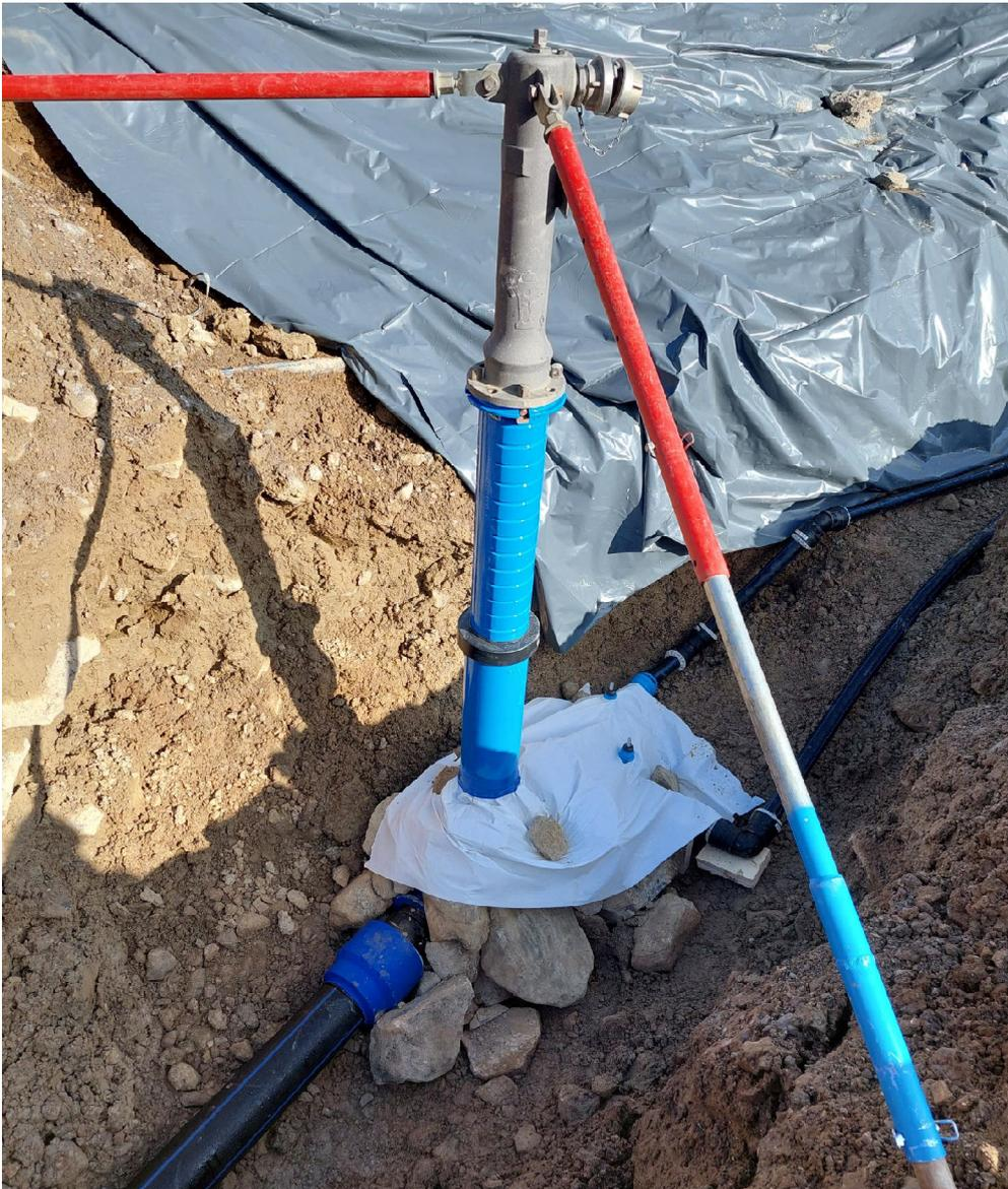
26.05.2023: Versetztes Hydranten-Unterteil mit preis. Oberteil und Anschlussleitungen aus PE.
