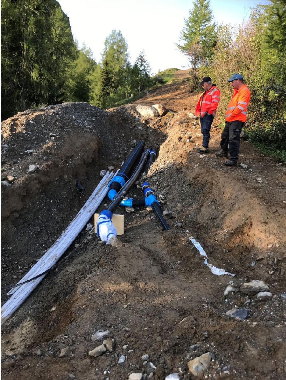
31.08.2023: Unterhalb Sammelschacht Farur befindet sich das Druckleitungsende PE DN315 (2023) und der provisorische Anschluss in die neue Zuleitung PD DN160 zum Druckreduzierschacht Farur.
